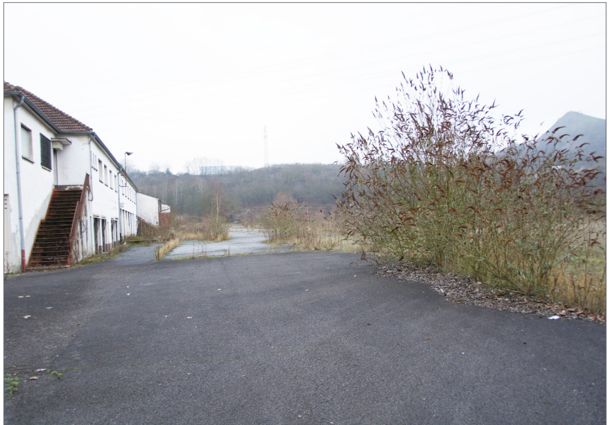
Blick von Osten in das Plangebiet mit gewerblicher Brache links im Bild
